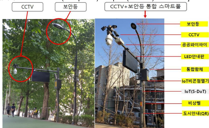
Figura 04 - Poste antes (à esquerda) e depois (à direita) das instalações de IoT
