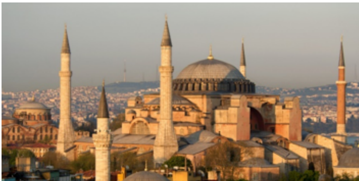
Fig 14 - Exterior da Basílica de Santa Sofia mostra multifaces. | Fonte: https://belostemplos.wordpress.com/2016/09/19/basilica-de-santa-sofia-turquia/
