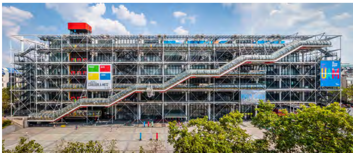
Foto 1: Centro Pompidou Fonte: www.archdaily.com.br
