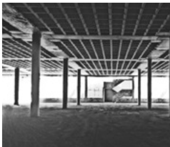
Fig 12 - Vista 4 primeiro subsolo TRF 2014
