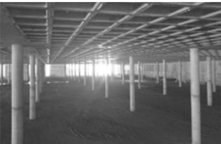
Fig 9 - Vista do primeiro subsolo TRF 2014
