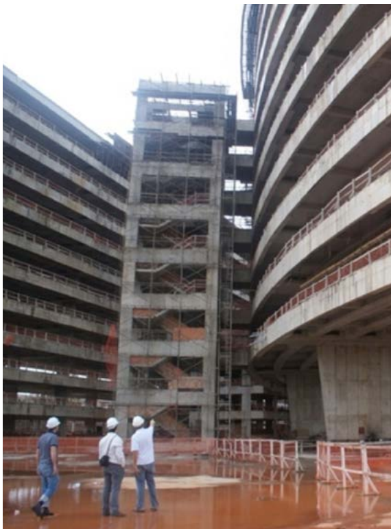
Fig 3 - Vista Oeste dos bloco A (administrativo) e bloco B (bloco de gabinetes) -março 2014
