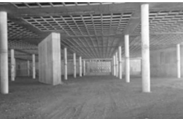
Fig 11 - Vista 3 primeiro subsolo TRF 2014
