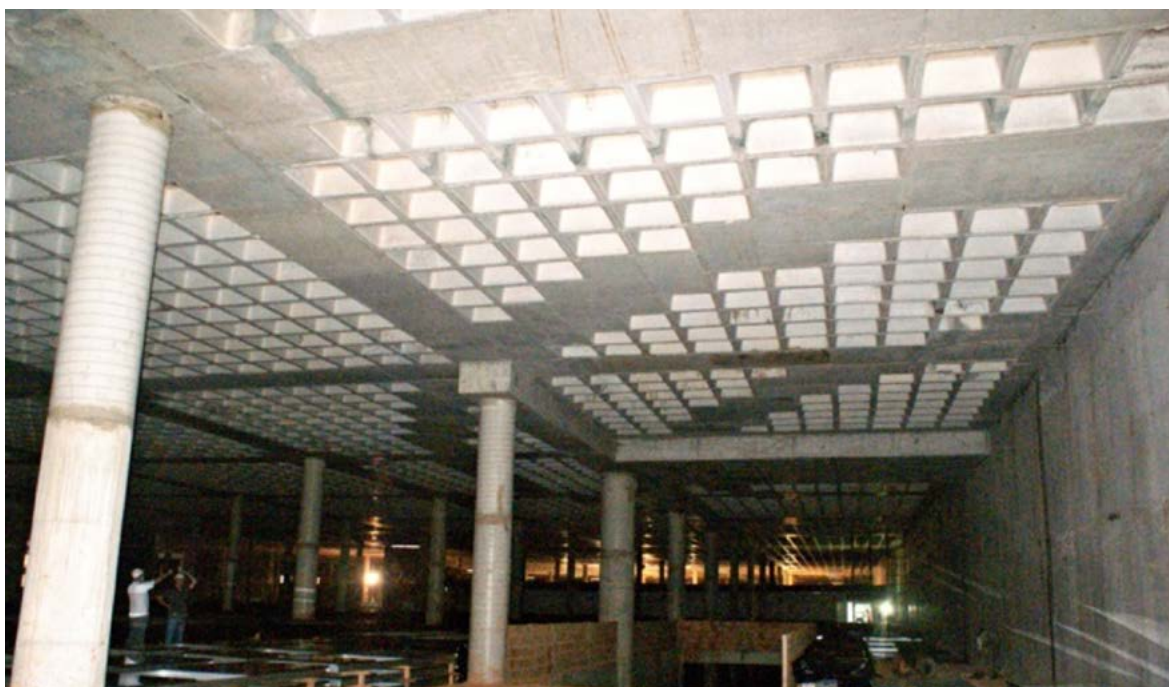
Fig 5 - Foto sub solo Fachada Sul Bloco B (gabinetes)
