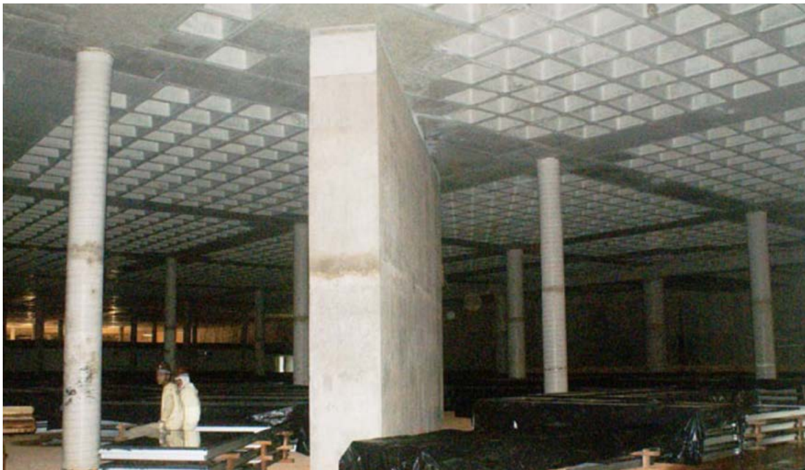
Fig 6 - Foto sub solo Bloco B (gabinetes) 03/2014
