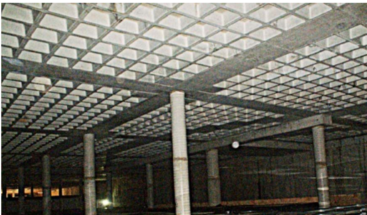
Fig 7 - Foto sub solo Bloco B (gabinetes) 03/2014
