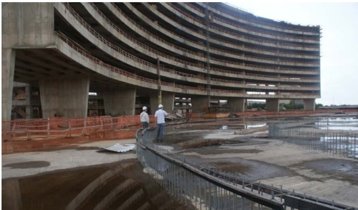
Fig 4 - Foto Fachada Sul Bloco B (gabinetes)
