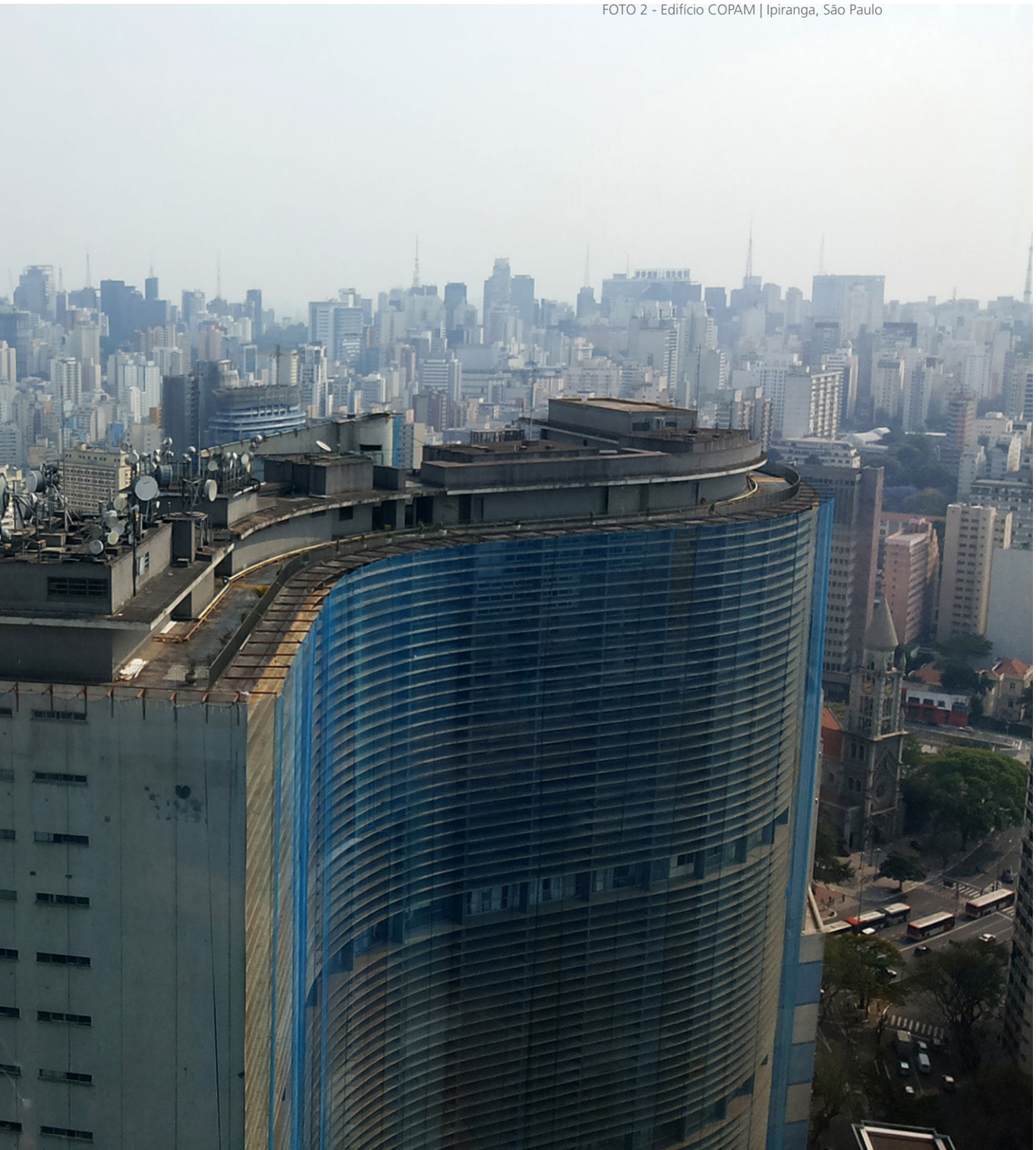
FOTO 2 - Edifício COPAM | Ipiranga, São Paulo
