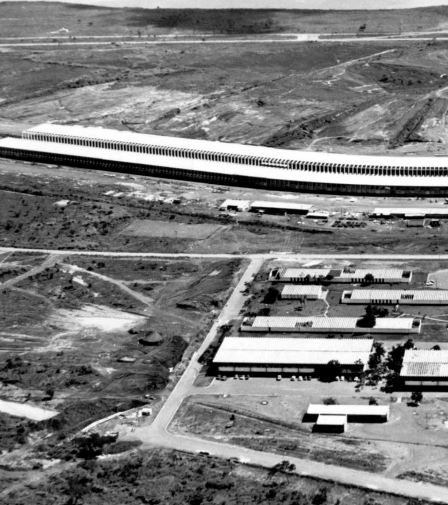
Fig 15 - ICC durante a construção. Fonte: http://faudarepressao.blogspot.com.br
