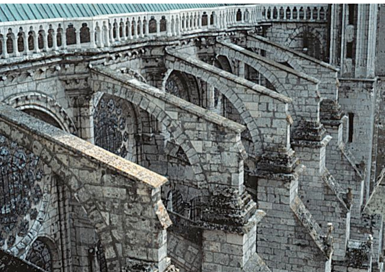
Fig 16 - Arcobotantes e contrafortes em Saint-Denis (séc XII). Fonte: www.montfort.org.br
