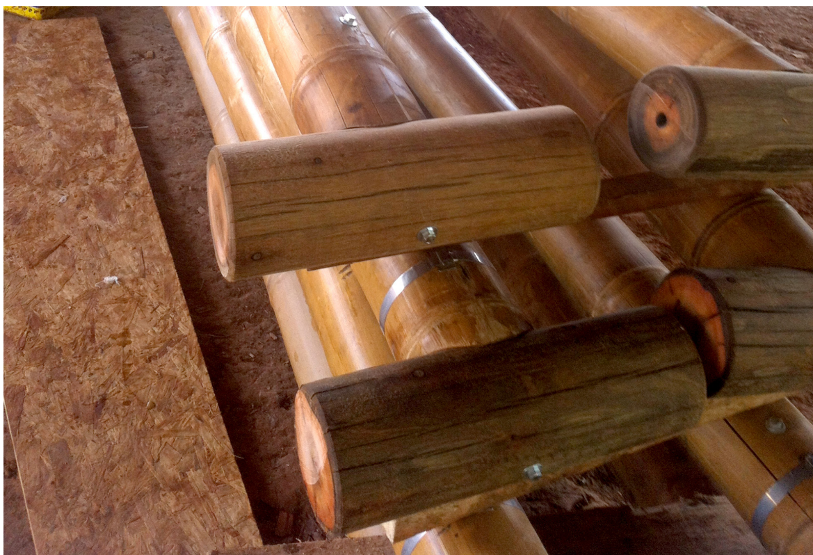
Fig 5 - Detalhe de peças de eucalipto torneado para padronização das uniões
