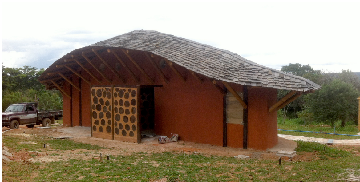
Fig 4 - Prédio de sanitários
