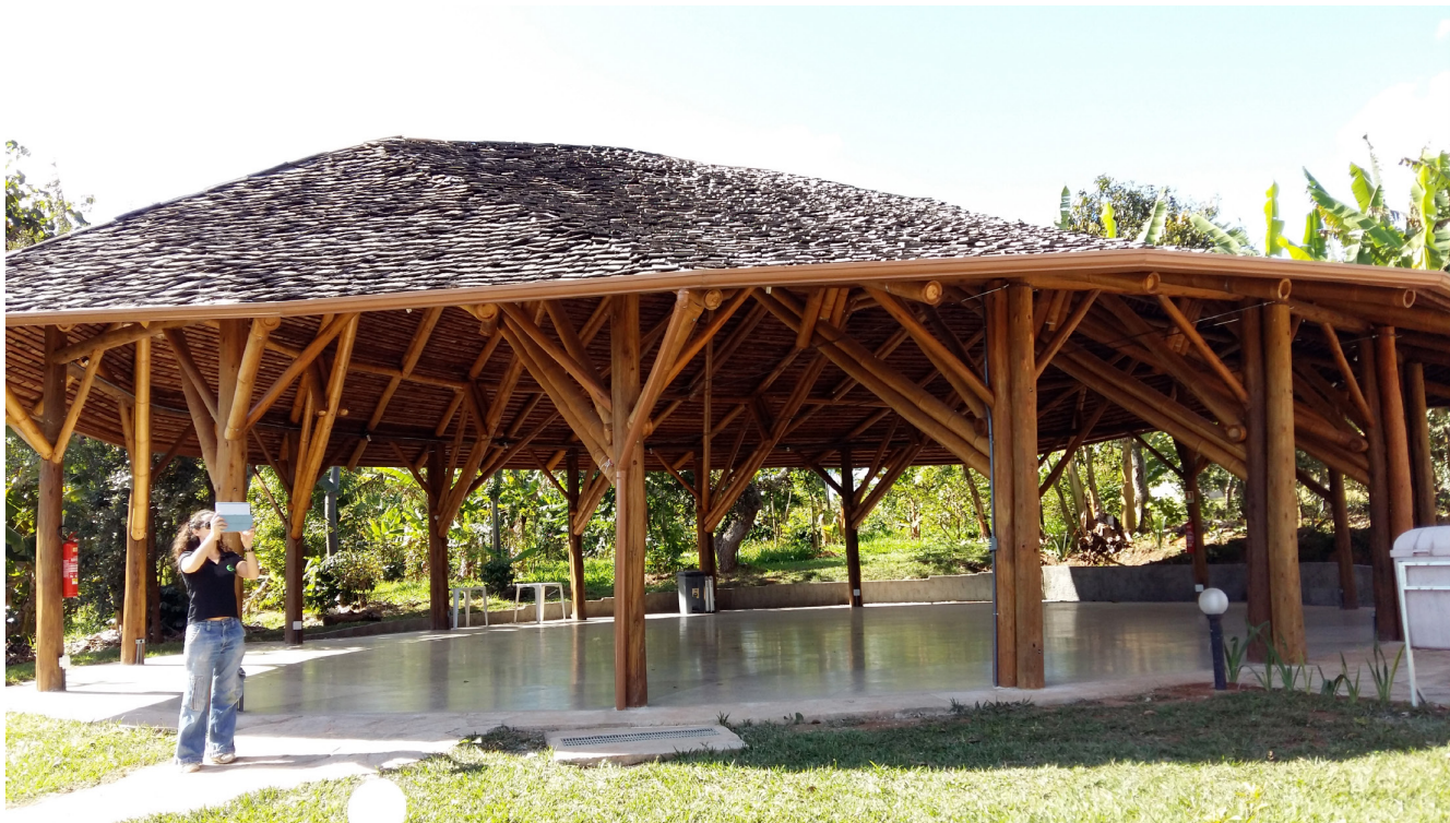
Fig 2 - Oca Prédio Multiuso - Paredes estruturais em Superadobe, vigas de amarração e fundações em concreto armado, estrutura da cobertura em bambu Dendrocalamus Asper com vão livre máximo de 9,50 metros, telhas de madeira e área de cobertura de 175 m 2
