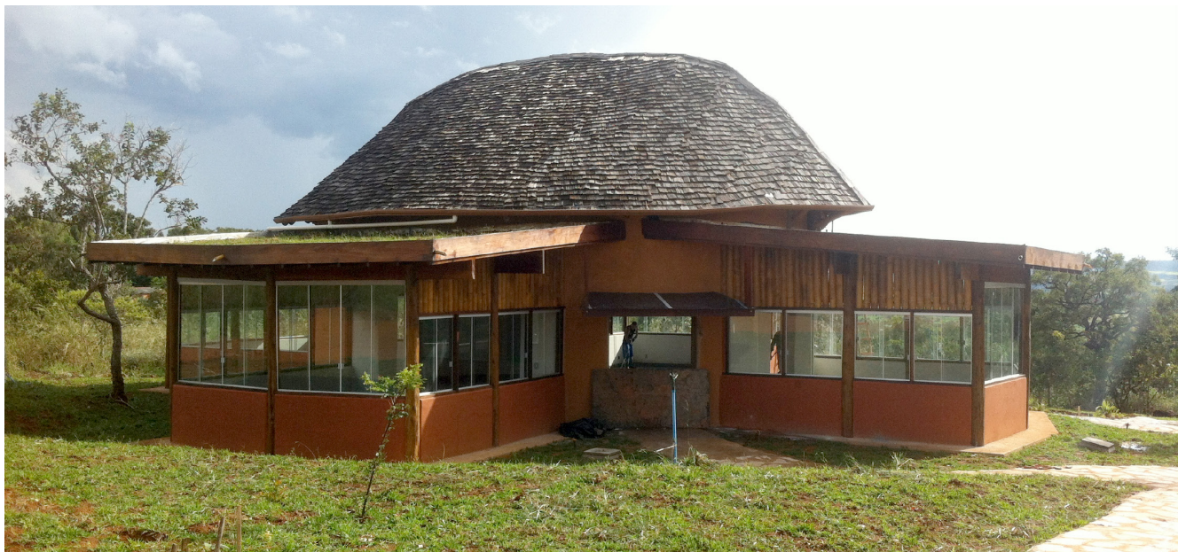
Fig 3 - Prédio Multiuso Prédio de sanitários - Paredes em Superadobe, vigas de amarração e fundações em concreto armado, estrutura da cobertura em bambu Dendrocalamus Asper , telhas de madeira e área de cobertura de 116 m
