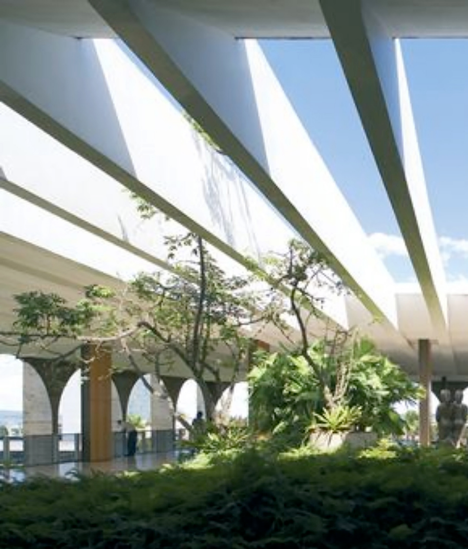
Fig 6 - Jardim/Varanda – Emoldurado pela cobertura do Palácio do Itamaraty Fonte: http://au.pini.com.br/arquitetura-urbanismo/226/artigo275973-3.aspx
