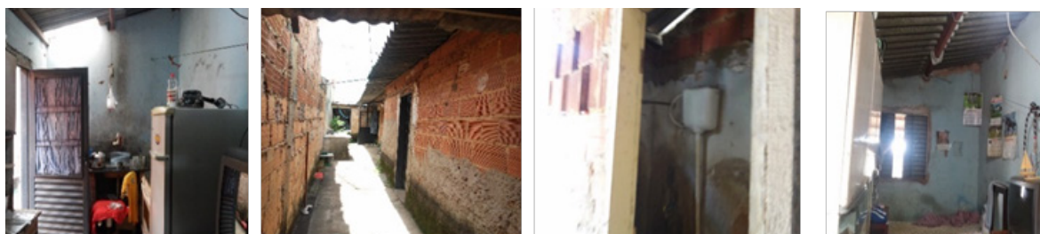
Fig 39 - Cozinha e corredor externo. Fonte: As autoras.
