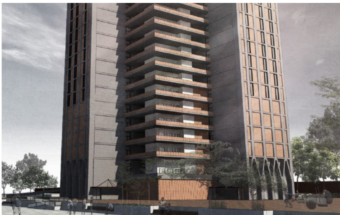
Figura 02. Vista externa do edifício
