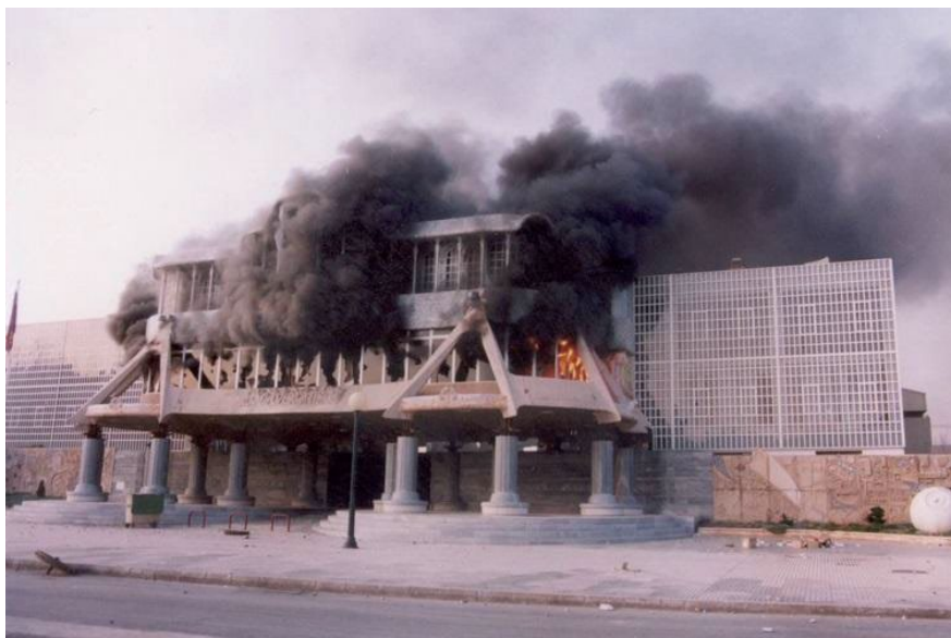
Figura 8: Incêndio na Assembleia da Região de Múrcia em 1992, El año del descubrimiento (Luis López Carrasco, 2020)
