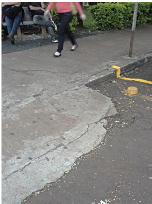
Figura 3 – Rampa de acesso ao passeio
